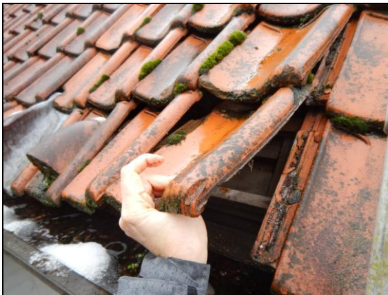
Figuur 8. Inspectie van sporen van vleermuizen en huismussen onder de dakpannen.
