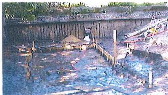
Afb 161 werkzaamheden aan de vijver in het voorjaar van 2013 (Foto's: P. van den Brandeler)
