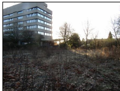
Figuur 4. Het gebouw vanaf de westelijke parkeerplaats.
