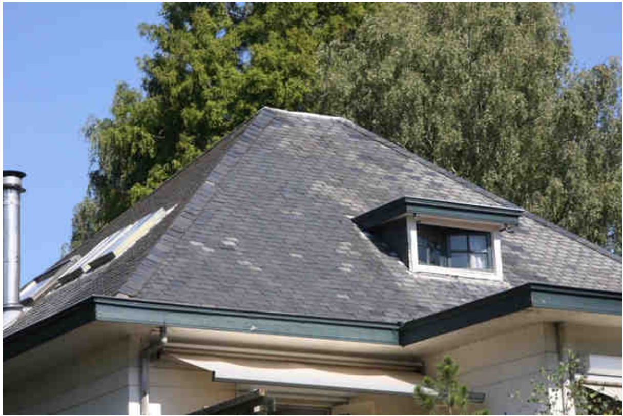
Afbeelding 12. Aanzicht dak nr. 5.
