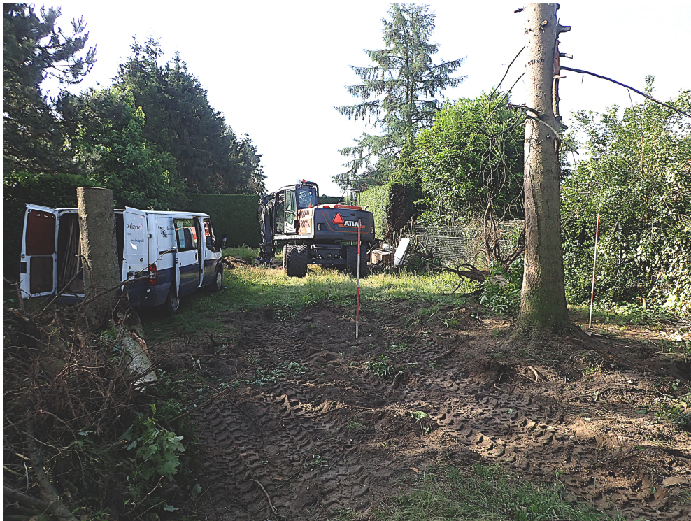
Figuur 5. Spankeren, Landweg 4: tussen de boomstronken in wordt er gestart met de aanleg van de proefsleuf.
