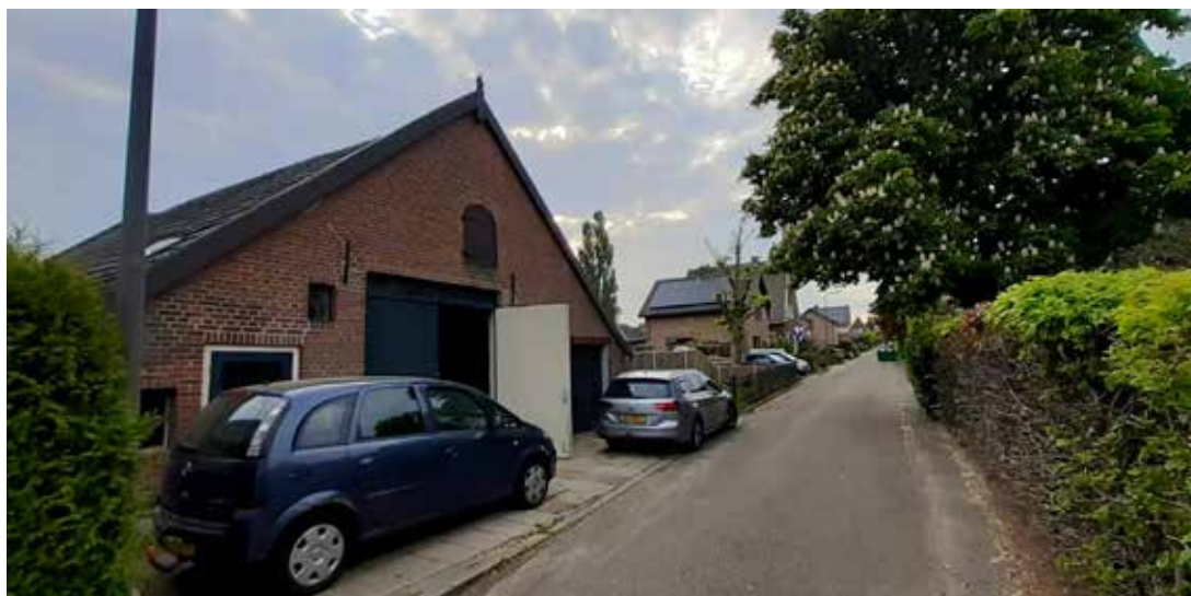
De te slopen schuur.
