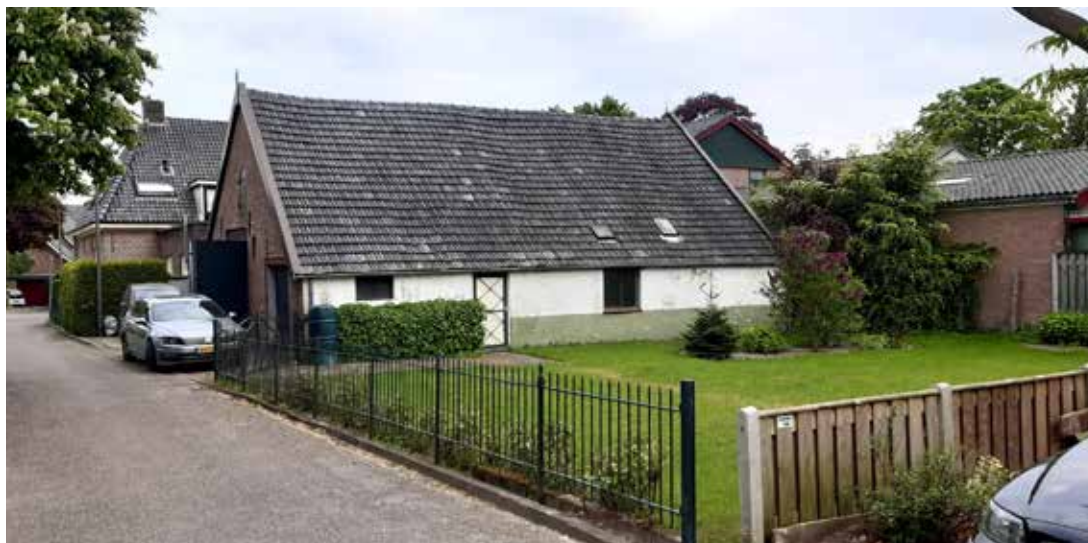
De te slopen schuur.
