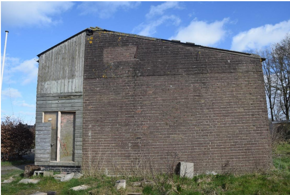
Foto 2: Gebouw in plangebied, westgevel.
