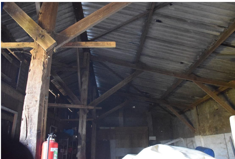
Foto 12 Binnenzijde gebouw. Golfplaten dak en houten dakconstructie.
