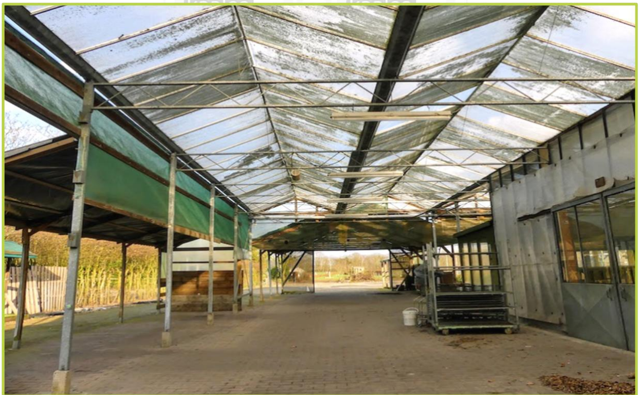
Afbeelding 6: Binnenkant van het gebouw met open zijkanten.
