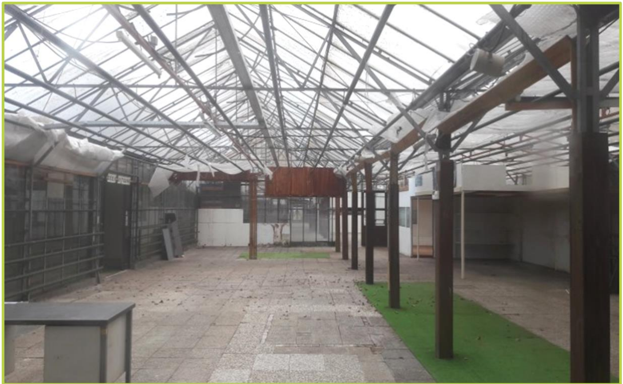
Afbeelding 5: Binnenkant van het gebouw met gesloten zijkanten.
