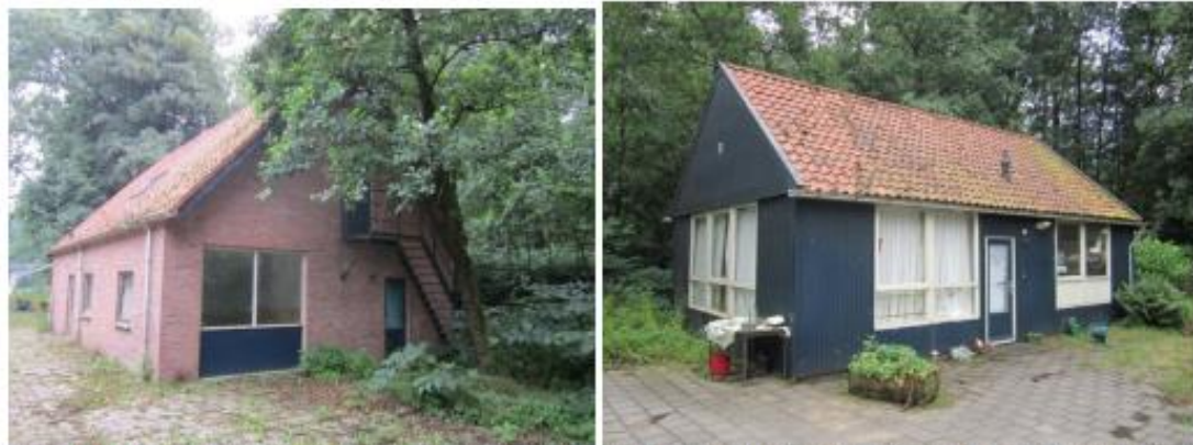
Achter de hal gelegen voormalige garage annex berging (links) en woning (rechts) (foto: Gelders Genootschap 2013).
