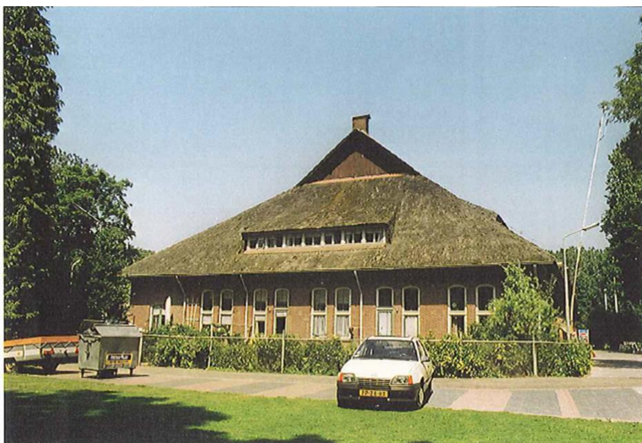
Foto uit Redengevende omschrijving Turnhal d.d. 21 december 1999.
