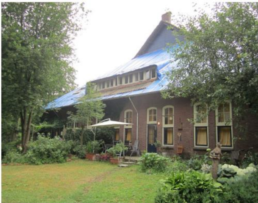
Rechter zijgevel met vergrootte vensteropeningen en toegevoegde dakkapel en deuopeningen (foto: Gelders Genoots
