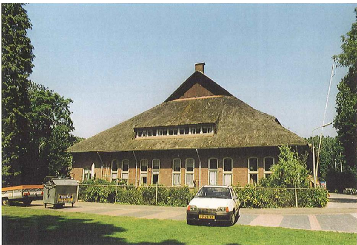
Foto uit Redengevende omschrijving Turnhal d.d. 21 december 1999.
