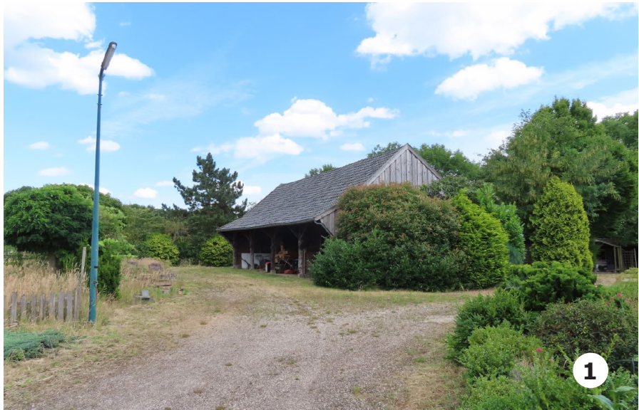
Kapschuur aan de noordzijde open, aan de zuidkant was de kwekerijwinkel; op het gehele terrein is het sortiment van de kwekerij terug te vinden
