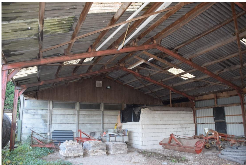
8 Open kapschuur aan de binnenzijde.
