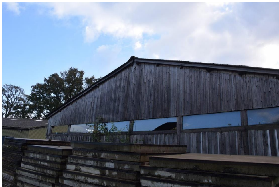
7 Buitenzijde open kapschuur.
