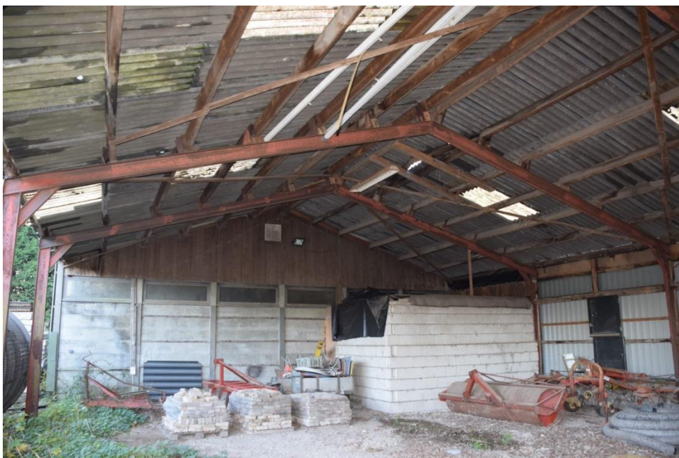
6 Open kapschuur aan de binnenzijde.
