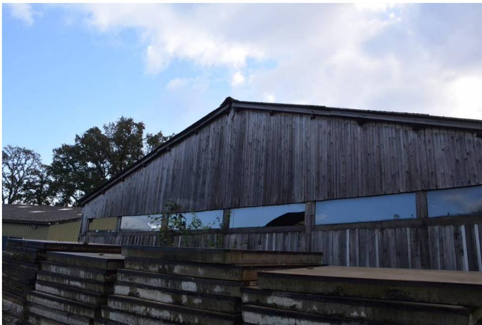
5 Buitenzijde open kapschuur.
