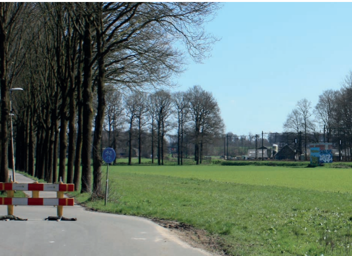
3.20 Trafo gezien vanaf kruising Biljoen
