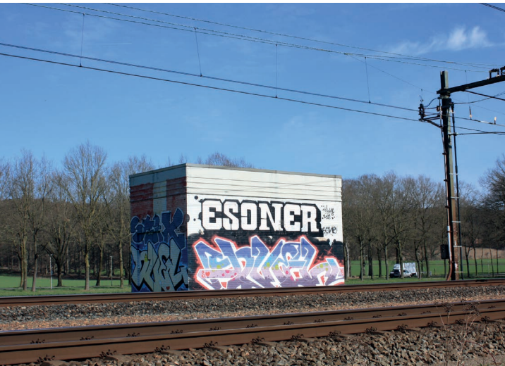
3.19 Trafo gezien vanaf zuidkant spoor
