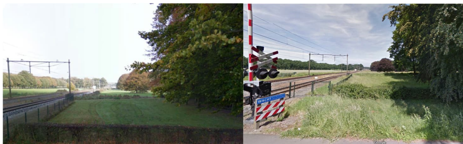
Figuur 5.4 Beelden gemaakt in oktober 2008 (links) en juni 2016 (rechts). Op deze beelden is te zien dat type N17.03 voor de aanleg van de weg niet aanwezig. Bron: Google Streetview, 2019.
