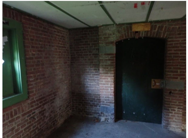
Foto 5: links, interieur van de begane grond met een verlaagd deel van de zolder met enkelvoudige wandjes.
