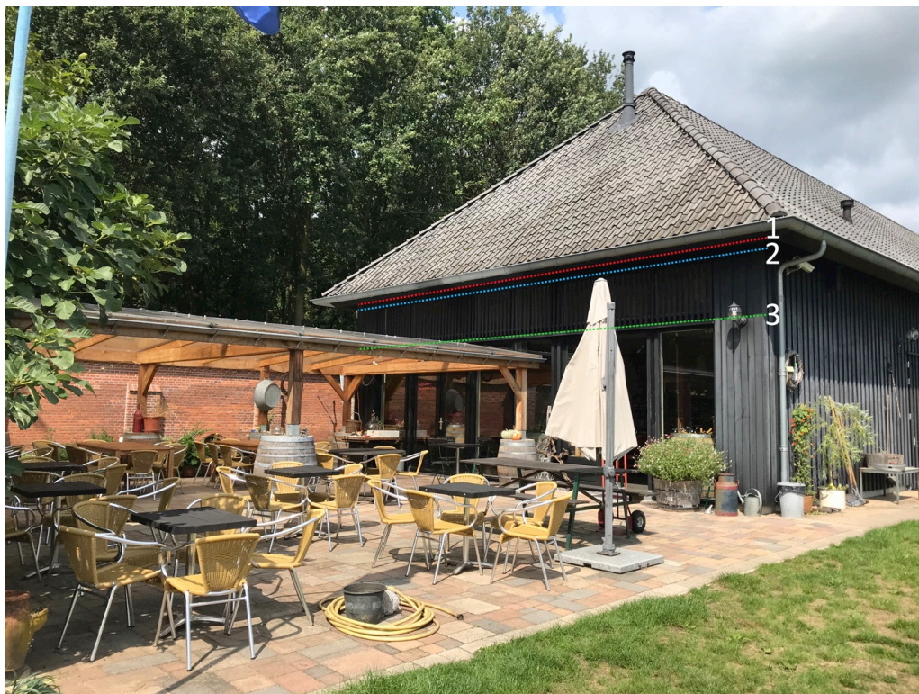
1 (rood): Afwerking dak zie detail foto, 2 (blauw): Afwerking nabij raam zie detail foto, 3 (groen): Hoogte nieuwe terrasoverkapping
