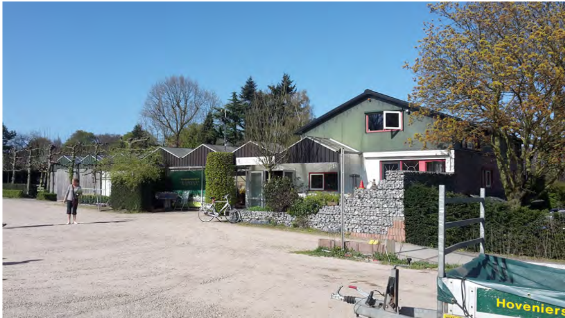
Bestaande situatie: kantoorgebouw en kassen
