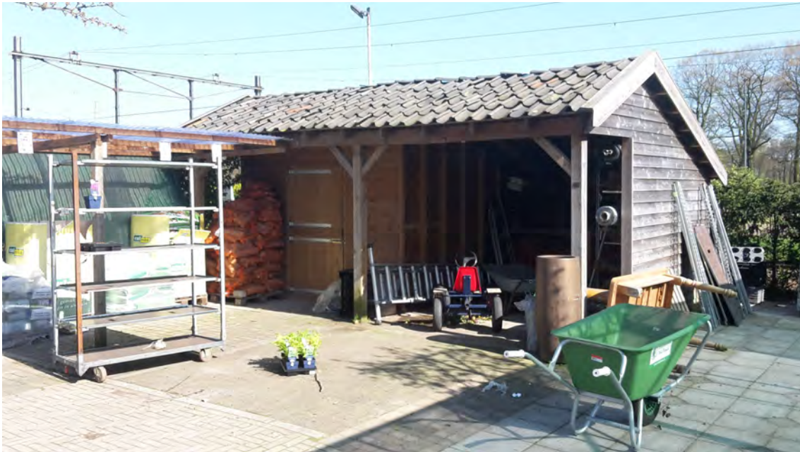
Bestaande situatie: de te slopen kapschuur achterop het terrein
