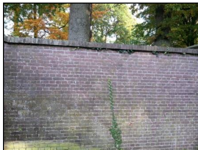
Figuur 8. Detailfoto muurdeel deellocatie 2.
