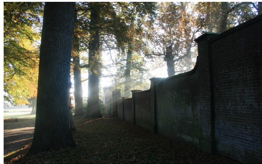
Zicht op tuinmuur A vanaf de Dwarslaan.
