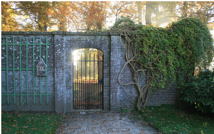
Zicht op tuinmuur B vanuit de binnentuin.
