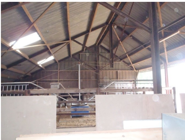
Foto 2: het interieur van de te slopen kapschuur. De enkelvoudige constructie is op deze foto goed zichtbaar. Nergens zijn hier holle ruimten aanwezig die kunnen dienen als vaste rust- en verblijfplaatsen voor diersoorten.
