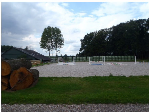
Foto 13: Overzicht van het gebied waar de rijhal moet komen. Links op de foto de te slopen kapschuur
