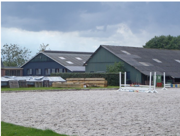
Foto 5: De te slopen kapschuur met daarnaast een van de twee stallen. Op de voorgrond de huidige paardrijbak.
