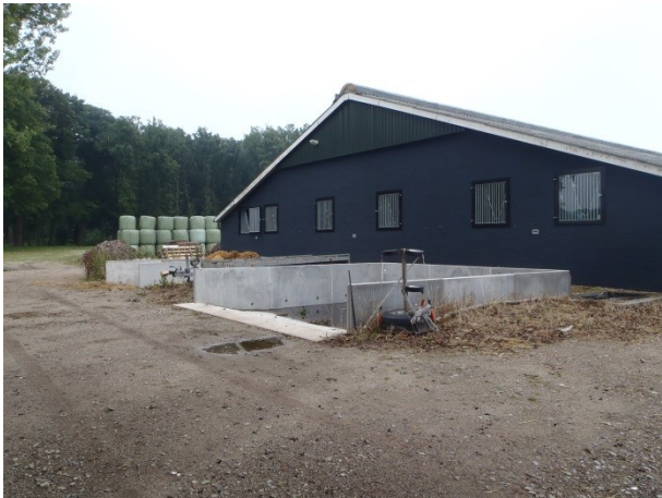
Foto 4: De stal van foto 3 gezien aan de achterzijde met daarvoor een betonnen mestopslag. De op de achtergrond aanwezige balen kuilgras staan op het bouwvlak.
