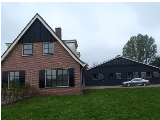
Foto 3: woonhuis/ toekomstig kantoor. Het pannendak is geschikt voor huismussen om te broeden de gevelbetimmering, de luiken en de stootvoegen vormen mogelijke verblijfplaatsen voor vleermuizen. Deze situatie blijft volledig intact. Werkzaamheden zijn hier niet voorzien. Naast het woonhuis is een van de stallen zichtbaar.
