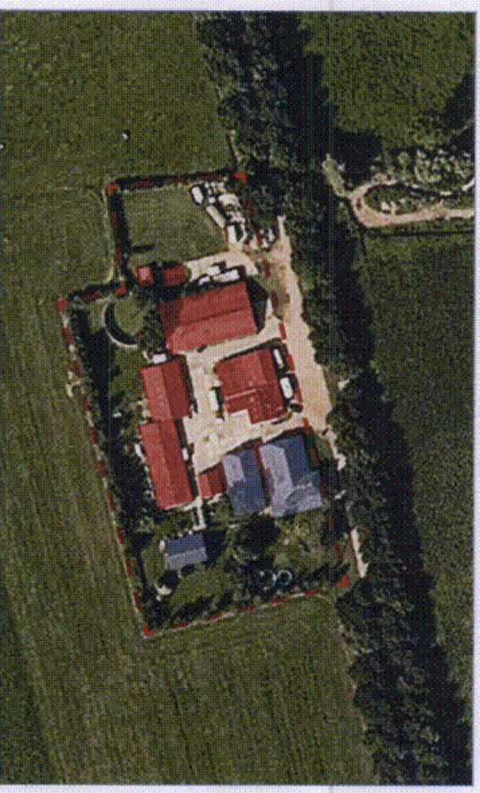
Luchtfoto van het erf, met in rood de gebouwen die gesloopt worden en in blauw de gebouwen die blijven staan. De rode stippe lijn geeft de erfgrans aan.
