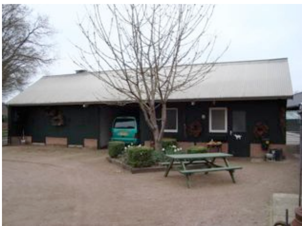
Foto 2: Zuidwesthoek terrein met bijgebouw.
