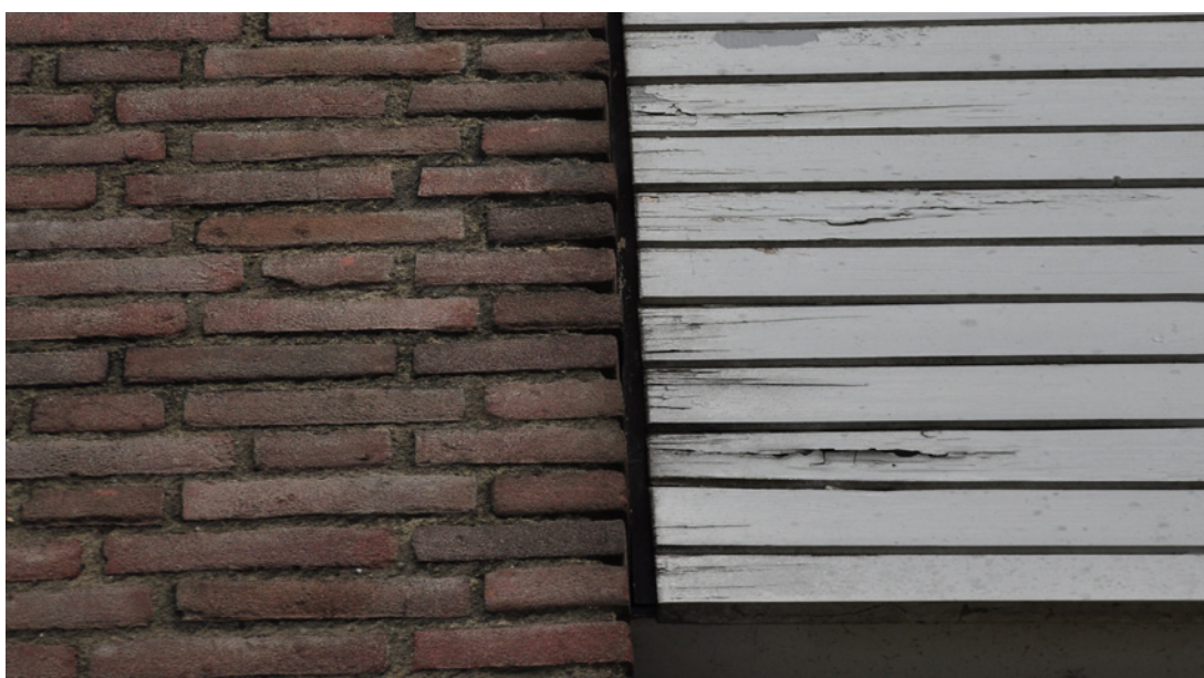
Hermetisch afgesloten kieren en gaten.
