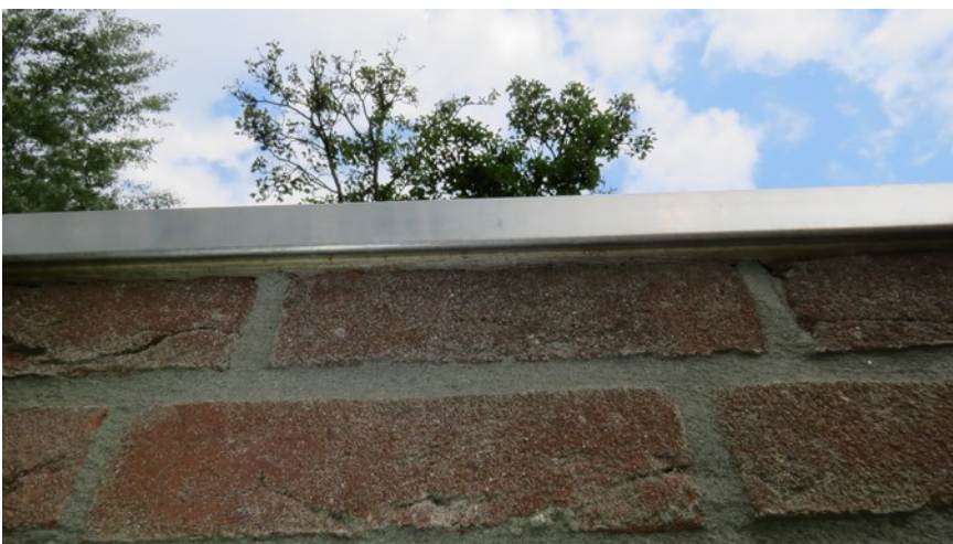
Afbeelding 33: Onder de daktrim van een bijgebouwtje is geen ruimte. Tevens is er geen spouwmuur aanwezig. Dit geldt voor alle bijgebouwen, kleine (halfopen) schuurtjes of fietsenstallingen waren volledig ongeschikt als vleermuisverblijfplaats.
