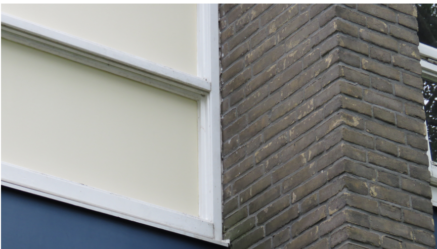
Afbeelding 32: Kozijnen sluiten goed aan op gevel, en - hoewel verweerd - lijkt de kitlaag nog goed sluitend aanwezig.
