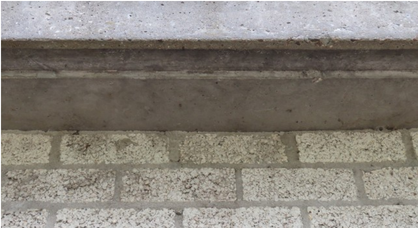
Afbeelding 22: Detail achterzijde gebouw A: Geen ruimte tussen baksteen en betonnen geveldeel.
