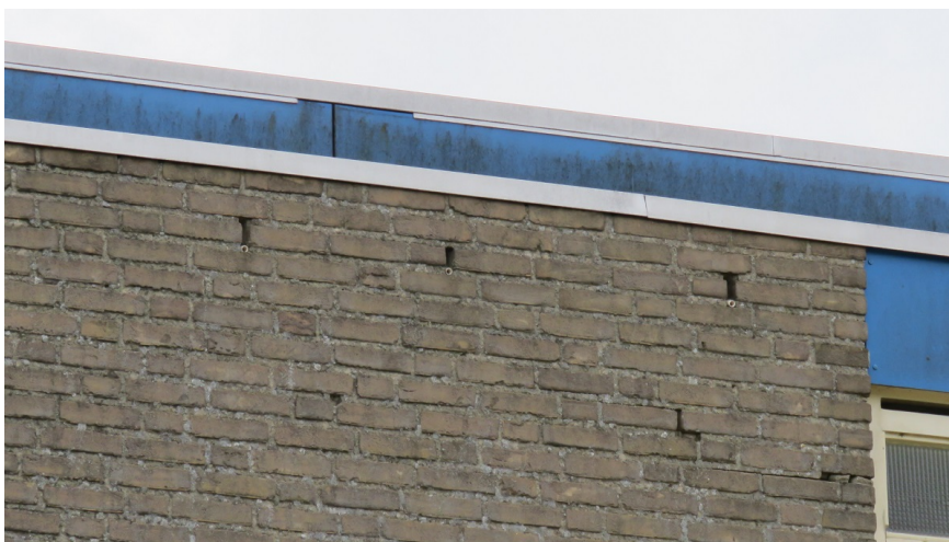
Afbeelding 12: Open stootvoegen kunnen vleermuizen toegang bieden tot geschikte verblijfplaatsen in de spouwmuur.
