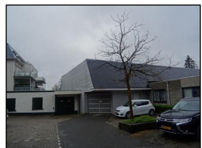
Figuur 8. Gebouw aan de achterzijde tegen de bebouwing op de onderzoekslocatie. Dit gebouw blijft behouden.
