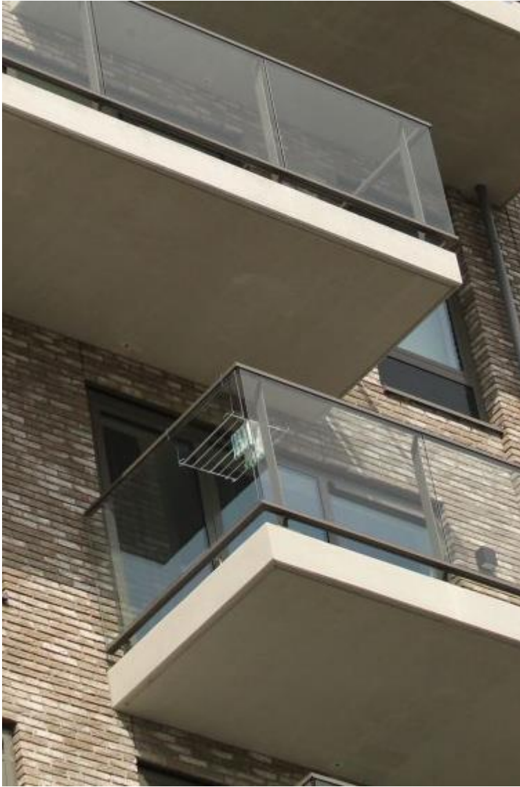
Prefab beton balkons, banden en dakrand
