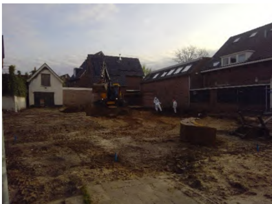
Foto 7 start ontgraving lood en zink verontreiging
