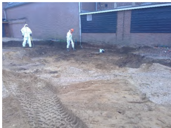
Foto 8 ontgraving met o.o. begeleiding
