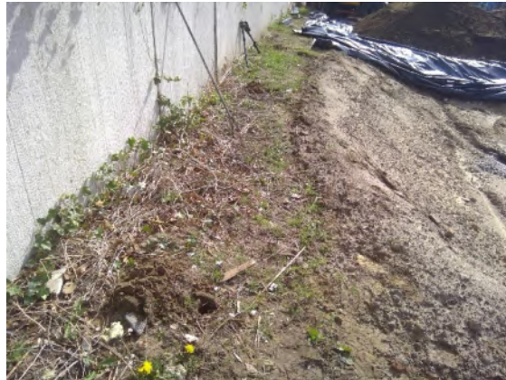
Foto 6 boringen 0,5 meter uit keerwand
