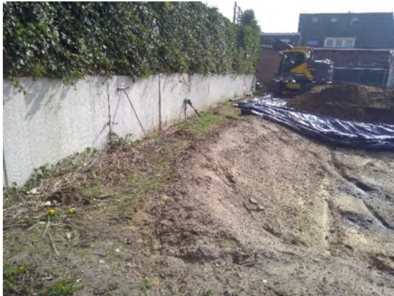
Foto 5 onderzoek langs keerwand ivm restverontreiging
