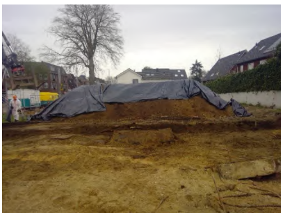
Foto 11 vrijgegraven ondergrondse tank nr. 73/73a
