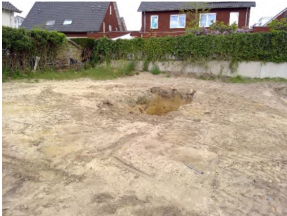
Foto 3 situatie tankgat na sanering
