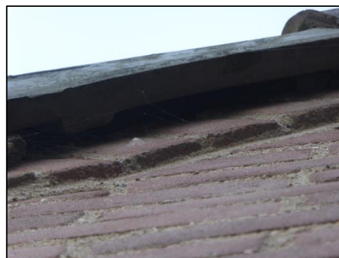
Noordseweg 2, ruimte achter dakpan.
