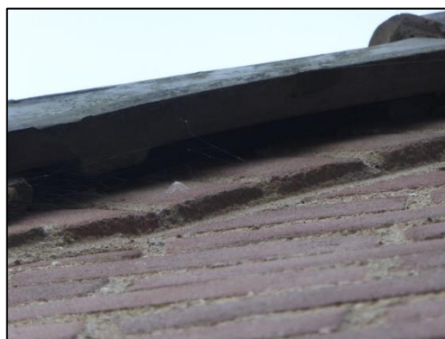
Noordseweg 2, ruimte achter dakpan.
