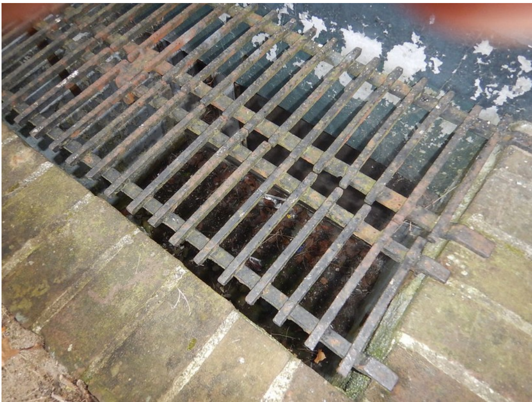
Figuur 8: Kelder onder woonhuis.
