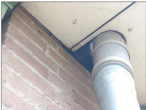
Afbeelding 3.2 en 3.3. Openingen onder dakbeschot en open stootvoegen
