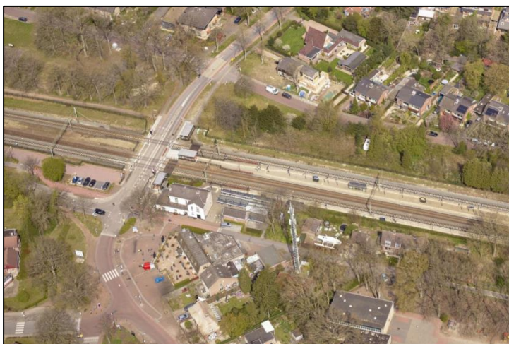
Luchtfoto plangebied 2021 (kijkrichting naar het noorden), station Wolfheze en huidige spoorovergang van de Wolfhezerweg (Bron: Geo-obliek; Slagboom en Peeters)
