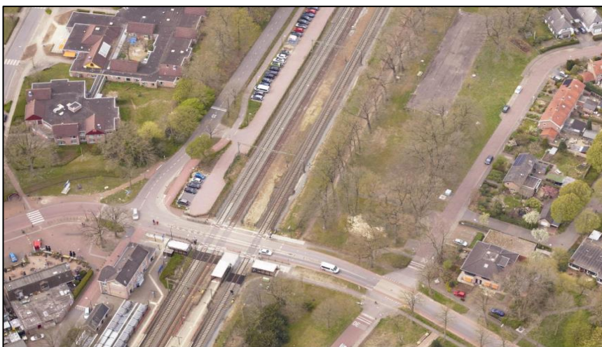
Luchtfoto plangebied 2021 (kijkrichting naar het westen). Onderaan het station Wolfheze en de huidige spoorovergang van de Wolfhezerweg. Links de parallelweg langs het spoor en rechts de Van Mesdagweg nabij het spoor (bron: Geo-obliek; Slagboom en Peeters)
