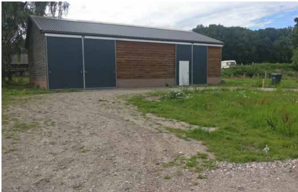
Schuur met puinverharding vanuit het westen gezien.
