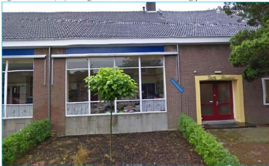
Figuur 1: locatie (vm)-ondergrondse HBO-tank met ontluuchtingspunt
