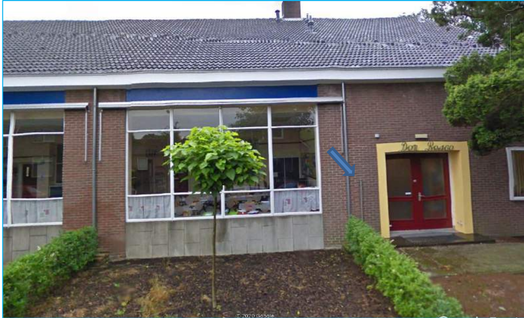
Figuur 1: locatie (vm)-ondergrondse HBO-tank met ontluuchtingspunt
