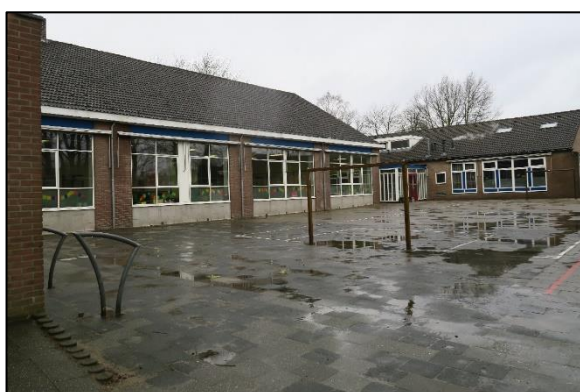
Foto 3. Schoolplein en schoolgebouw
