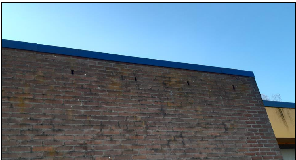
Open stootvoegen aan de oostzijde van het gebouw van de Dorendal
