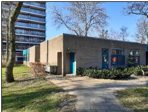
Het Trefpunt gezien vanuit het zuidoosten.
