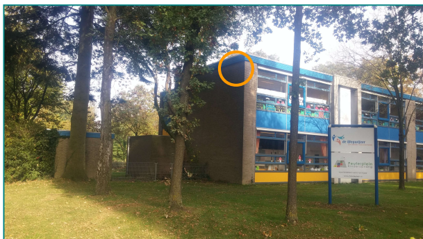
Foto 1: Paarverblijfplaats in open stootvoeg in de westgevel van De Wegwijzer.
