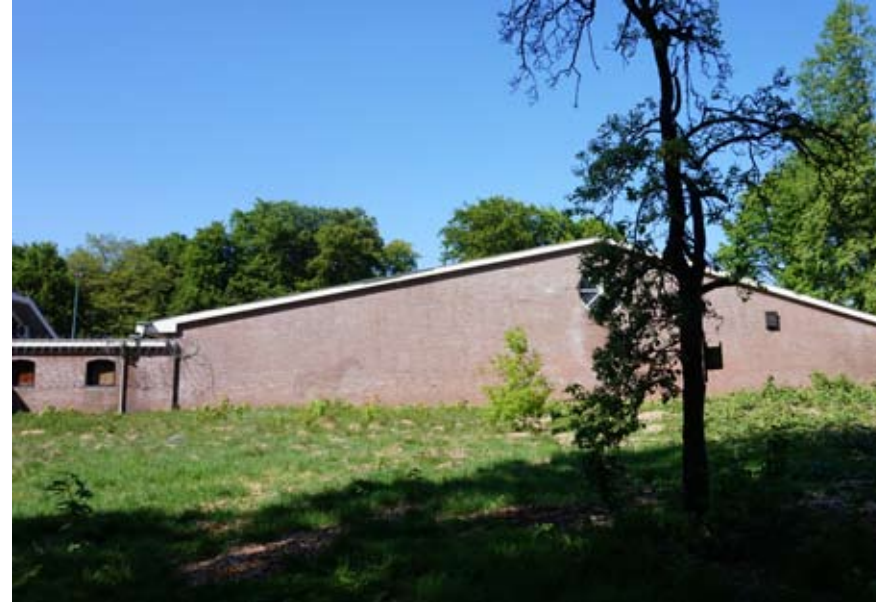
Huidige zuidgevel stal
