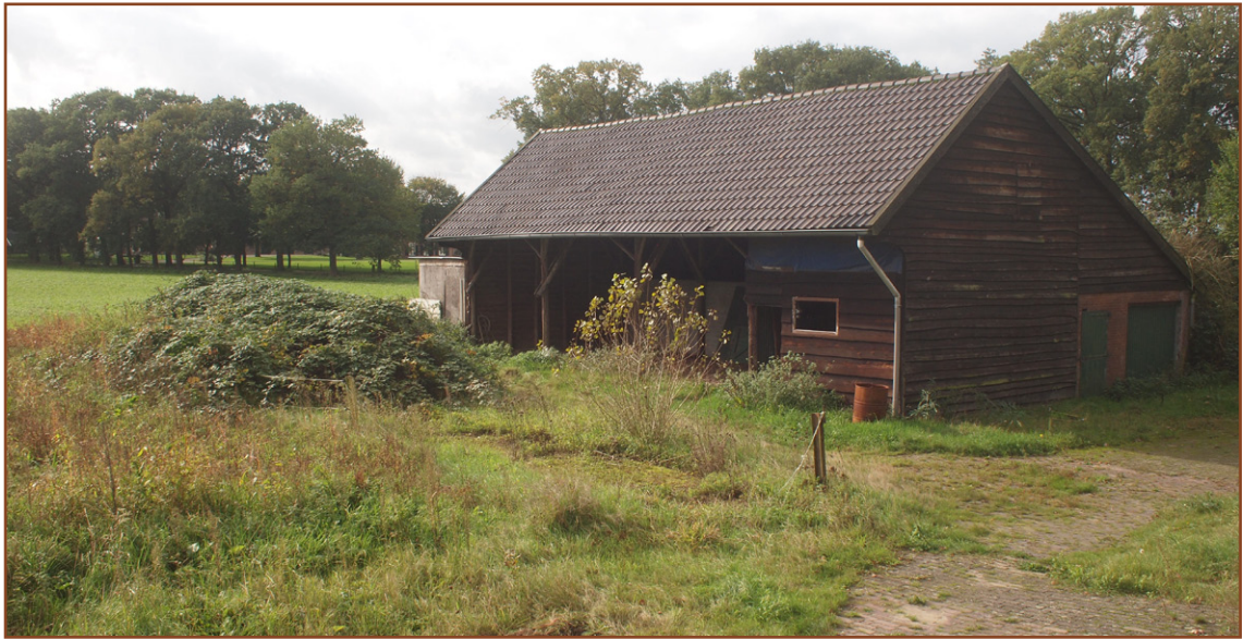
Afb. 2.6: Beeld van de kapschuur met verblijfplaats van Kerkuil en mogelijk vleermuizen. Het terrein rondom de kapschuur is niet meer in beheer en deels verruigd met braamopslag.
