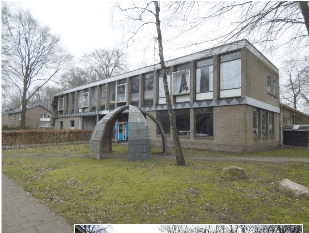
Het voormalige schoolgebouw aan de voorzijde met ingang
