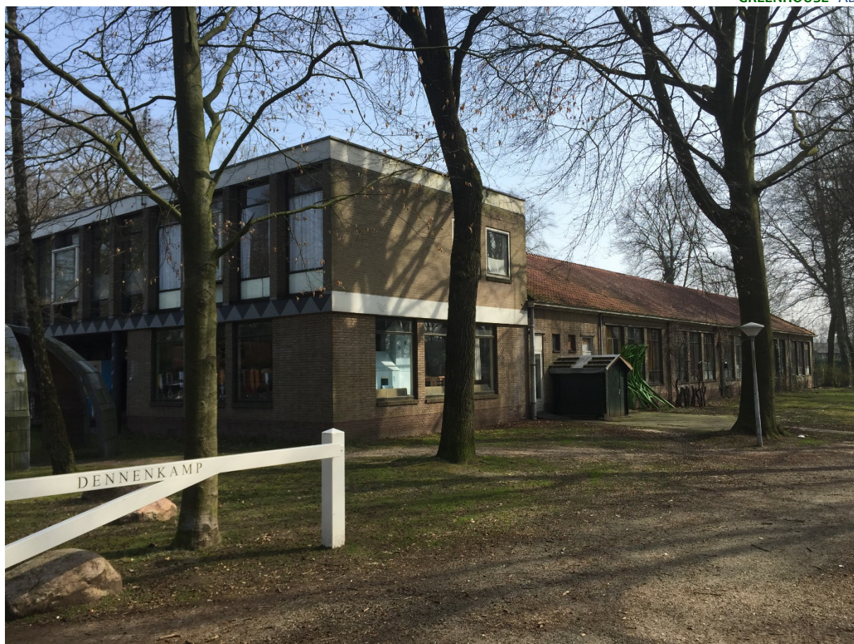
Afbeelding 2.2: Huidige situatie gezien richting het noordoosten.
