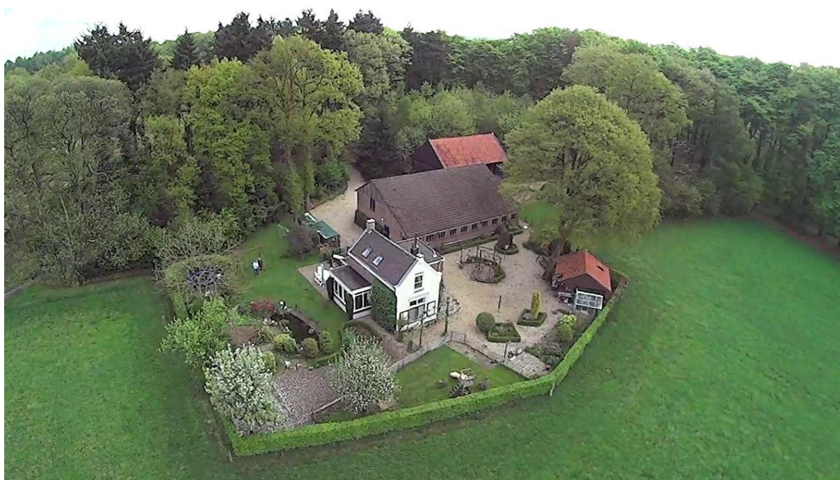
Huidige bebouwing Sonnenberglaan 3
