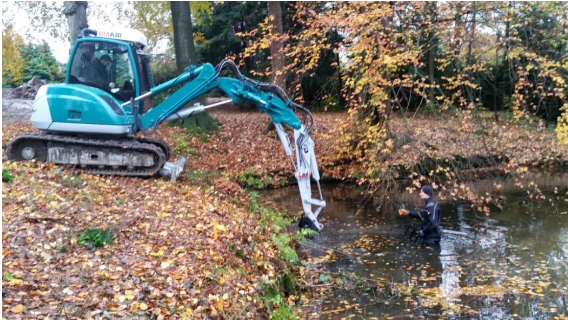
Figuur 4: Onderzoek in vijver (bron: archief REASeuro)
