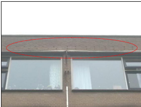
Figuur 12. Open stootvoegen.
