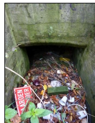
Figuur 13. Kelderruimte ter plaatse van voormalige kas.
