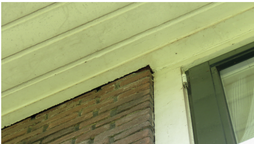
Afbeelding 11: Het dakoverstek van het woonhuis sluit zeer nauw, maar op enkele plekken zijn toch kieren zichtbaar die geschikt kunnen zijn voor vleermuizen.
