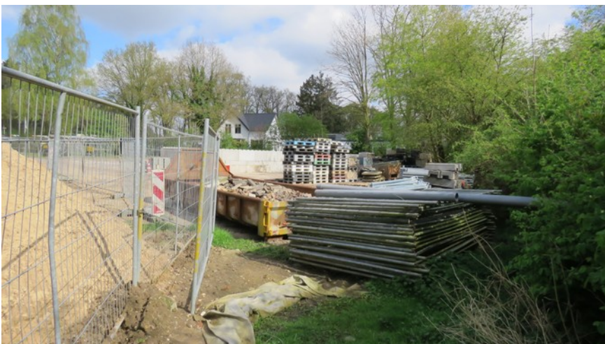
Afbeelding 3: Het centrale terreindeel et de opslag van divers materiaal (op de locatie van de twee voormalige opstallen).
