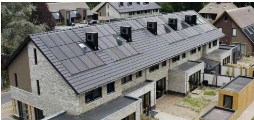
Figuur 3.26 Impressie van warmtepompen die als schoorsteen zijn opgenomen in het ontwerp van de woning (bron: BDP en gemeente Putten)
