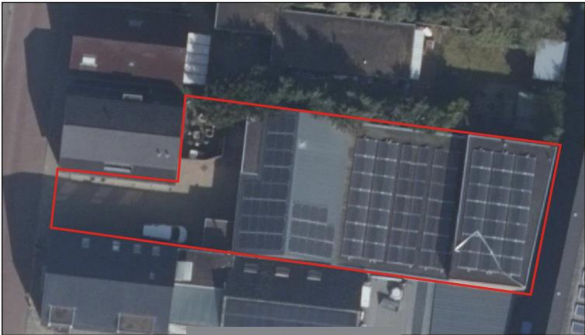
Afbeelding 2.1 Luchtfoto huidige situatie plangebied (Bron: P-dok)
