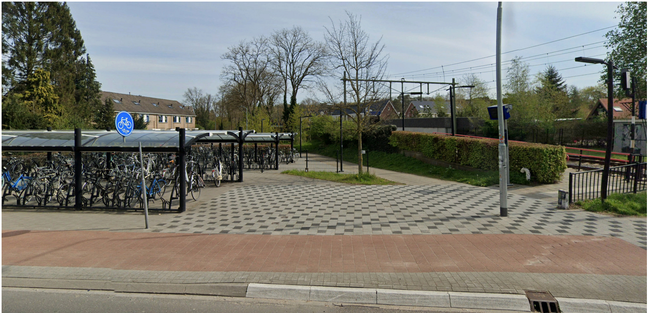
Huidige situatie (bron: Google Streetview)
